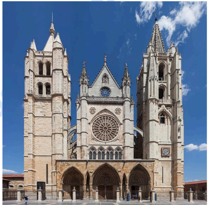
Imatge 2. Façana occidental de la catedral de Lleó Imagen 2. Fachada occidental de la catedral de León
